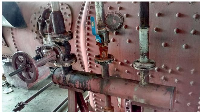
Imagem 05 Tubulação de vapor das caldeiras sem isolamento térmico e em condições precárias. (fonte: próprio autor)
