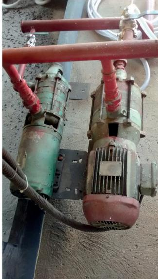
Imagem 08 Sistema de bombeamento para caldeiras com redundância ineficiente (capacidade de bombas diferentes). (fonte: próprio autor)
