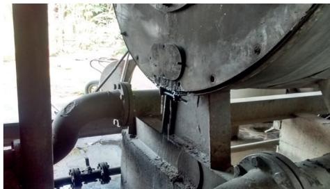
Imagem 07 Corpo de caldeira em condições precárias e com vazamento. (fonte: próprio autor)
