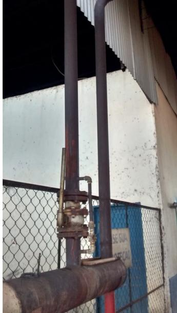
Imagem 06 Tubulação de vapor das caldeiras sem isolamento térmico. (fonte: próprio autor)
