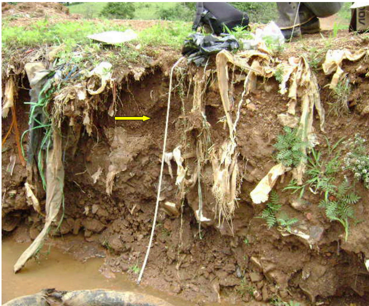
Figura 2. Ponto experimental - perfil III, borda do cone de dejeção em contato com o córrego das Antas (Anápolis-Go/Brasil) apresentando 1,30 m de espessura. Fita métrica (seta).
