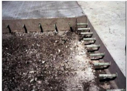
(b) armação do pavimento rígido
