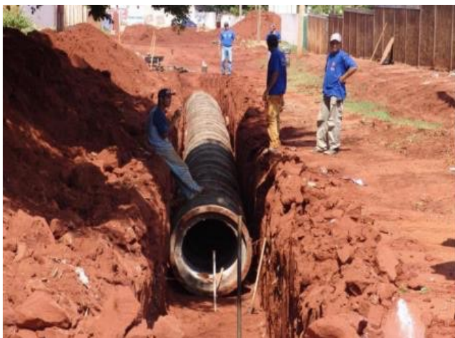
Figura 20 - Execução de Galeria unicelular.
